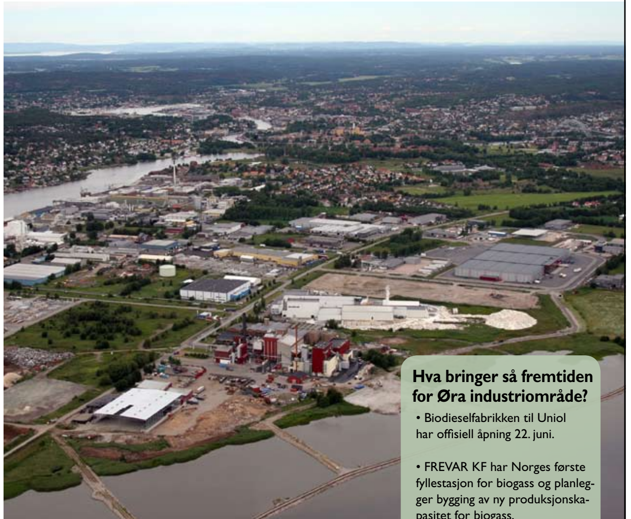
FREVAR KF, som eies 100 % av Fredrikstad kommune, står sentralt i nettverket av bedrifter på Øra.
